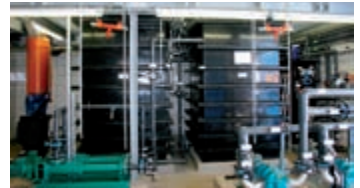
Filtration mit zwei Membran-Modulen
