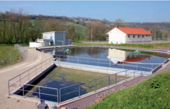
Kläranlage Ihn: das Belebungsbecken neben dem Funktionalgebäude mit Membranfiltration
